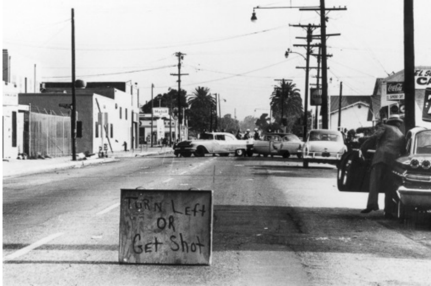
Panneau d'avertissement posé par la police durant les émeutes de Watts, Los Angeles, en août 1965 (p.70). Source : Getty Images
